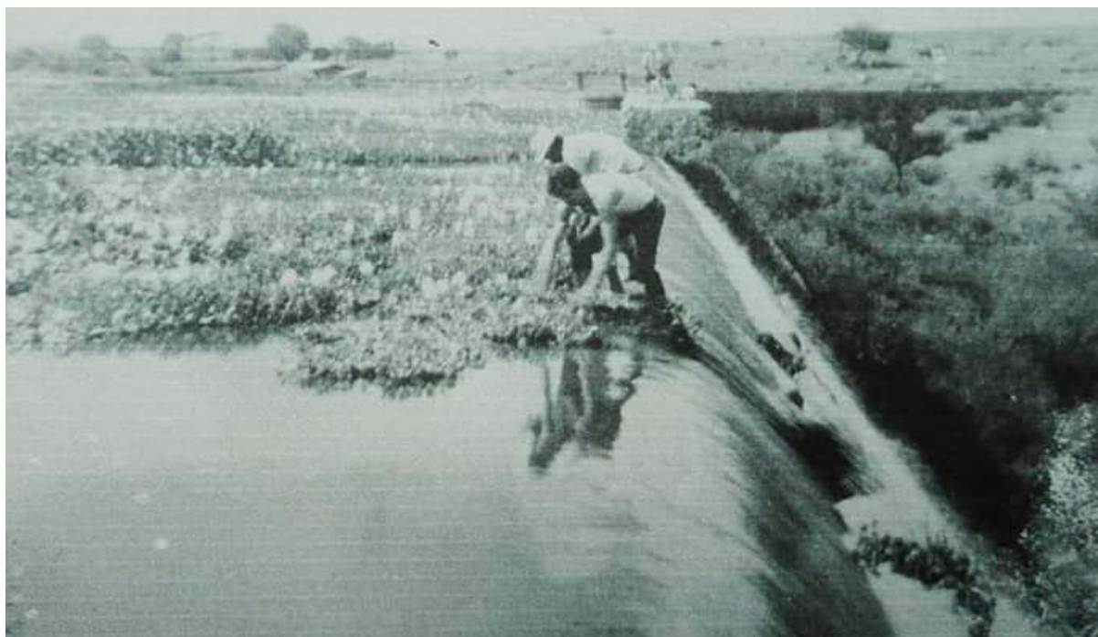
Figura 4. Limpieza de la cortina de la presa De Osorio, CA. 1990. AHT, Archivo Fotográfico de Comunicación Social.
